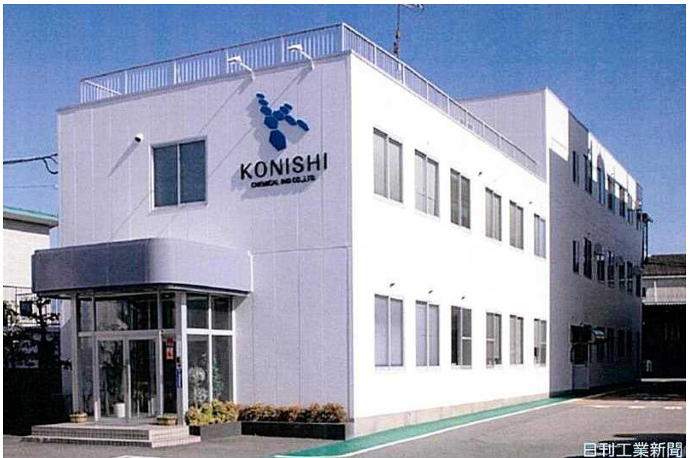
新設する試作プラントにケイ素系製造設備を導入する(小西化学工業本社)
